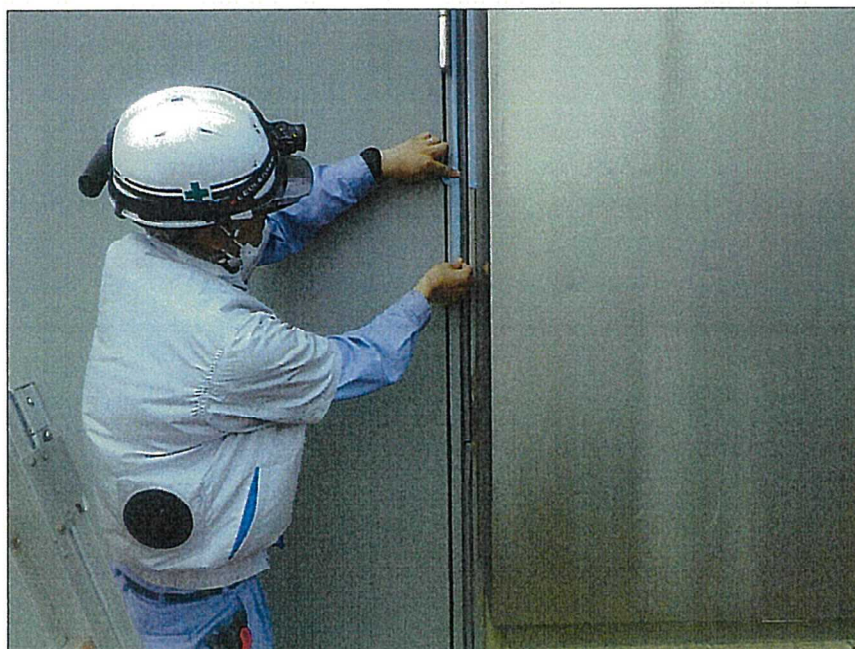
写真区分:シーリング工事 工種:施工状況 写真タイトル:テープ養生
