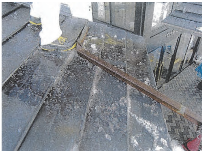
〈拡大①〉 雪止めの破損
