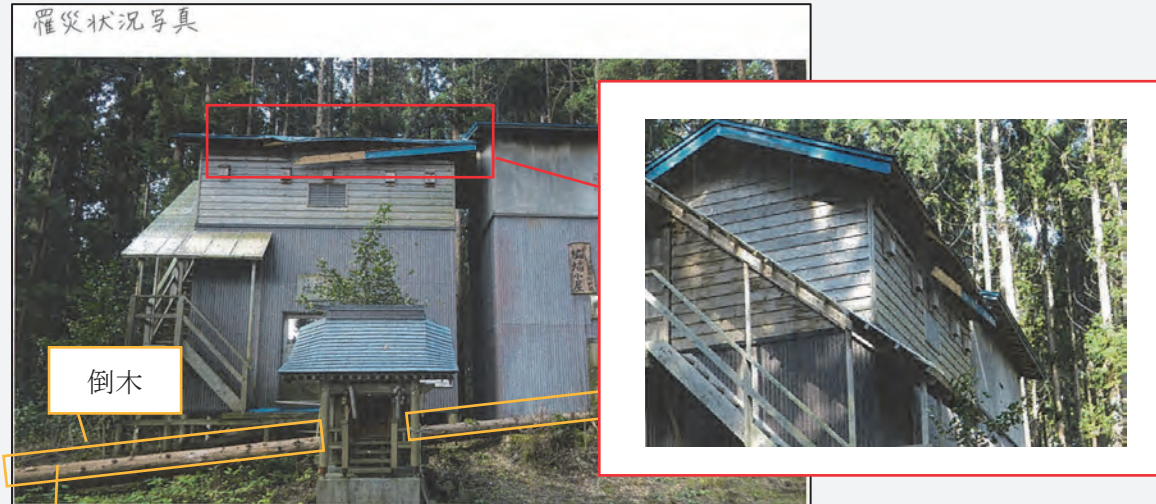
〈修理前〉倒木と屋根の破損が確認できる
