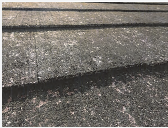
〈写真⑩〉屋根の反り（経年による）
