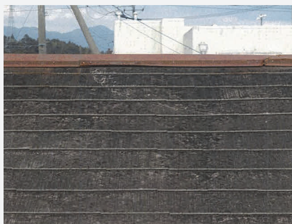
〈写真⑥〉 棟板金の傷み
