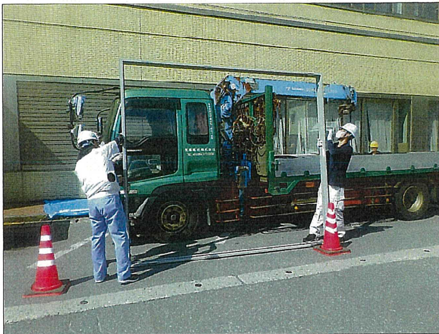
写真区分: 建具修繕工事 工種: 材料写真 写真タイトル: 枠材料搬入
