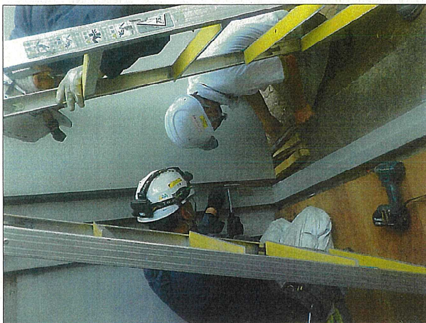
写真区分: 建具修繕工事 工種: 施工状況 写真タイトル: 建具吊り込み 状況
