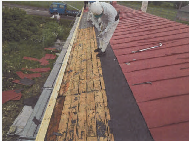
〈修理中③〉 野地板締め直し
