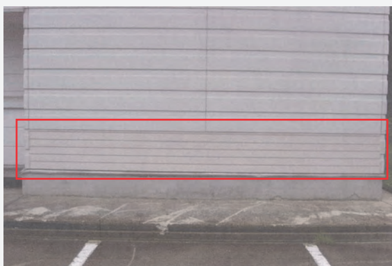
〈写真③〉 修理後。破損した外壁下部のみの交換。
