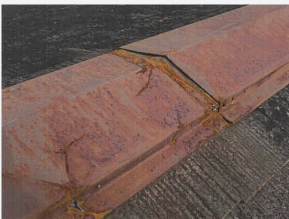
〈写真⑧〉 棟板金の傷み
