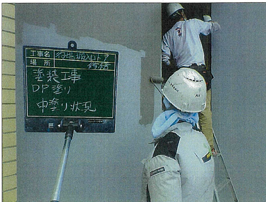
写真区分: 塗装工事 工種: 施工状況 写真タイトル: 中塗り状況
