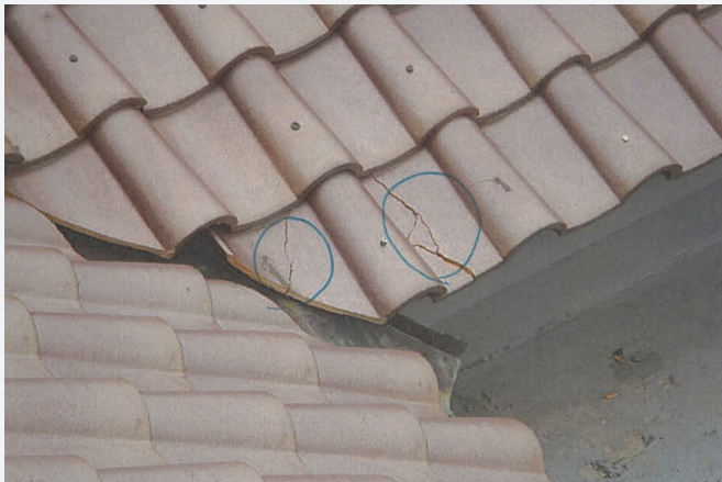
〈修理前④〉破損状況が確認できる。
