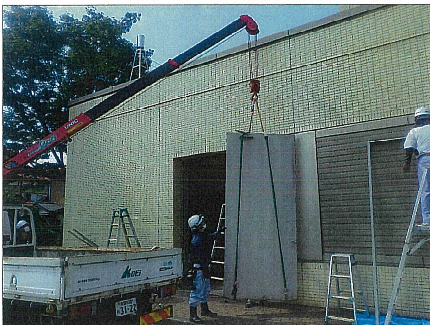
写真区分: 建具修繕工事 工種: 施工状況 写真タイトル: 既存建具撤去
