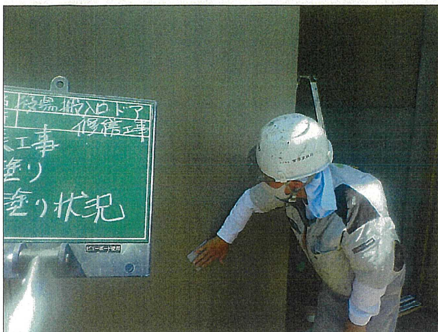
写真区分: 塗装工事 工種: 施工状況 写真タイトル: 中塗り研磨紙 ずり状況
