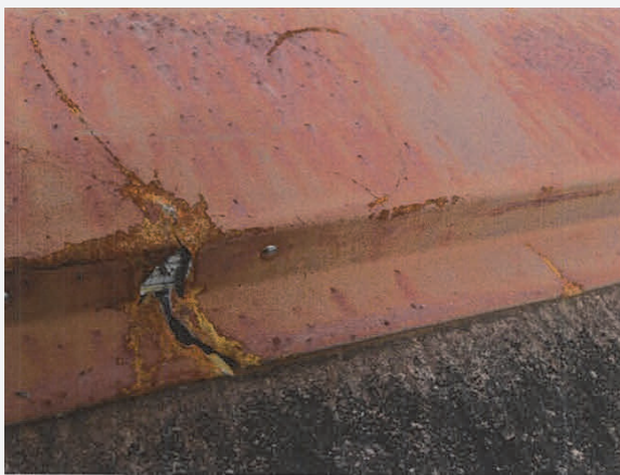
〈写真⑦〉 棟板金の傷み
