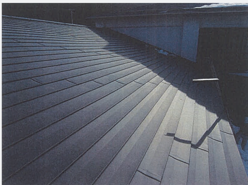
〈修理後〉コーキングで屋根を修繕した後に、雪止めを再設置。
