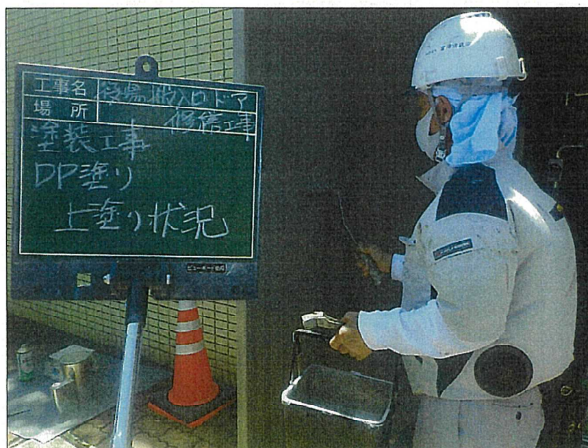
写真区分: 塗装工事 工種: 施工状況 写真タイトル: 上塗り状況
