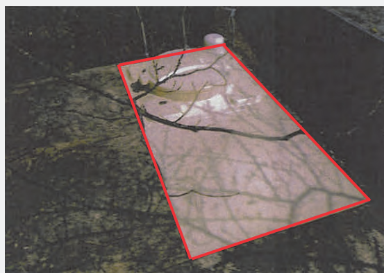
〈修理後①〉 破損箇所のみ交換。
