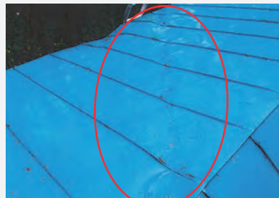
〈修理前〉下から撮影した写真では確認できない屋根の破損が確認できる。
