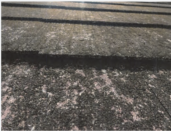
〈写真⑨〉屋根の反り（経年による）
