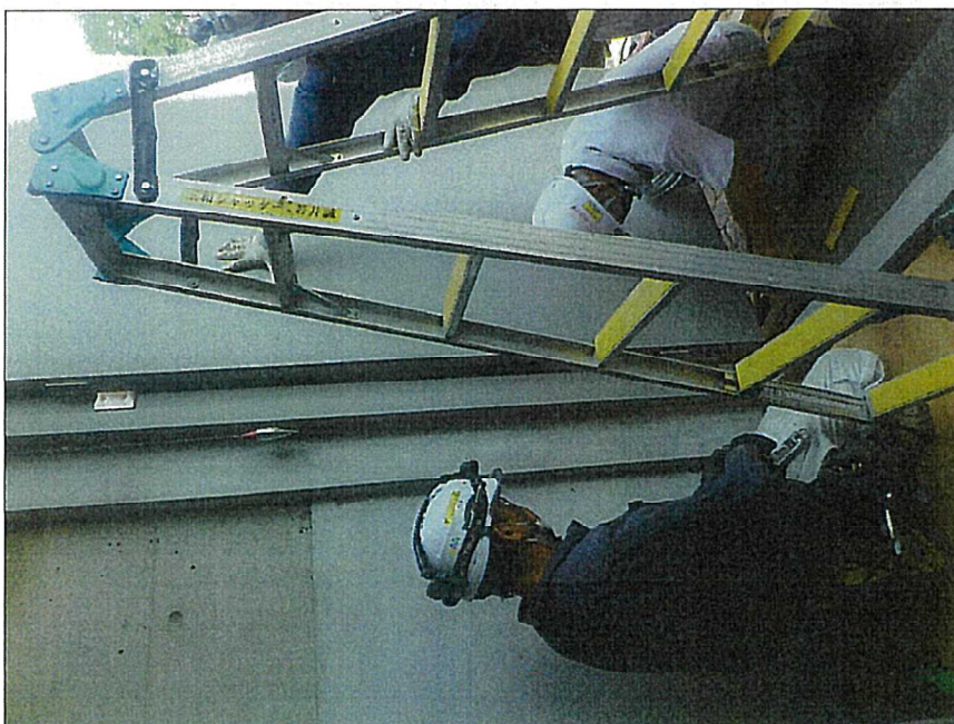
写真区分: 建具修繕工事 工種: 施工状況 写真タイトル: 枠建て込み状況
