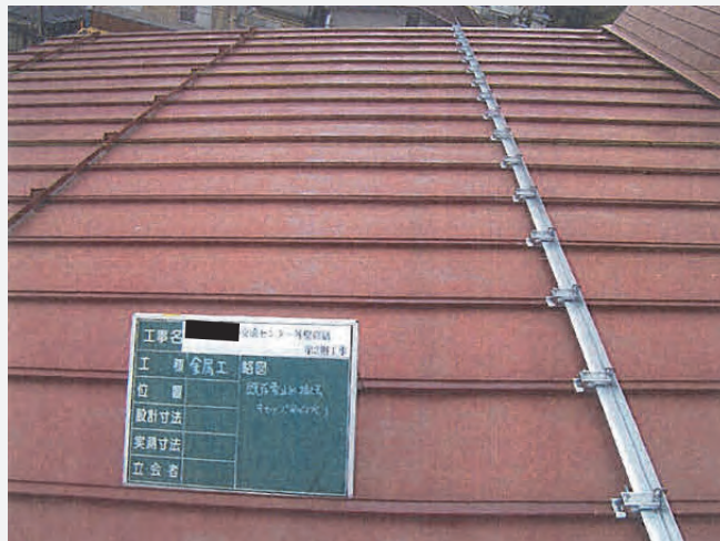
〈修理中④〉 雪止め復旧完了
