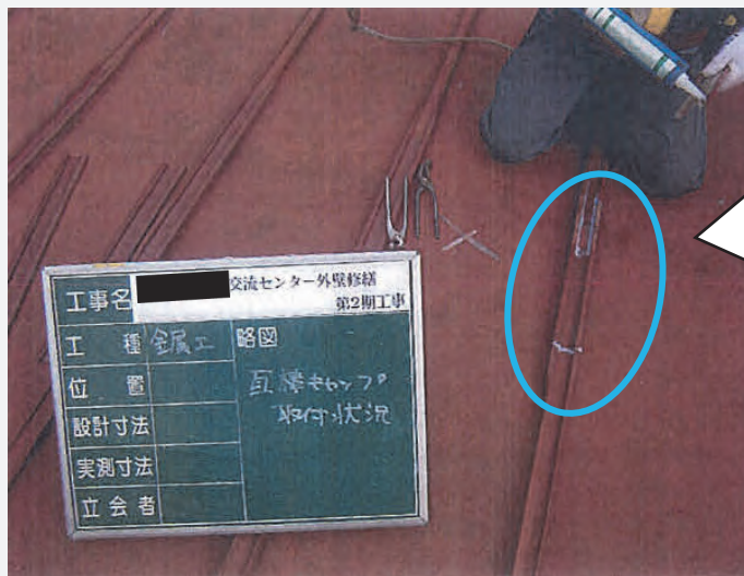
〈修理中①〉瓦状キャップ取付状況
