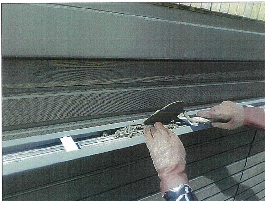
写真区分: 建具修繕工事 工種: 施工状況 写真タイトル: 下枠モルタル 詰め
