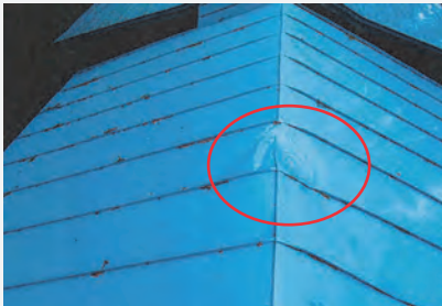
〈修理前〉下から撮影した写真では確認できない屋根の破損が確認できる。
