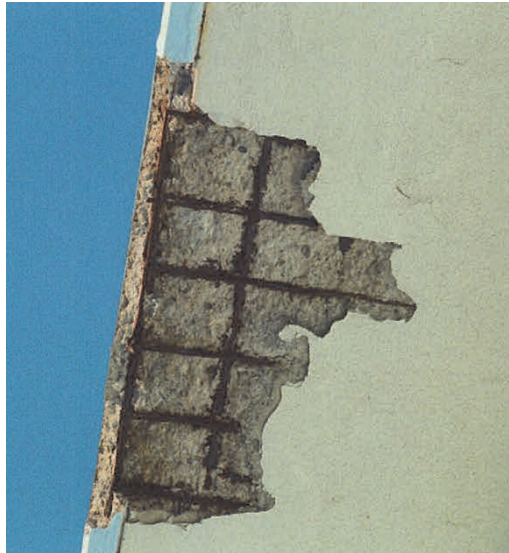
〈落下場所拡大〉鉄筋の錆が確認できる
