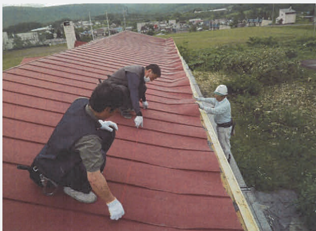
〈修理中②〉 貼り替え部既存撤去 損害箇所のみ剥がしている。
