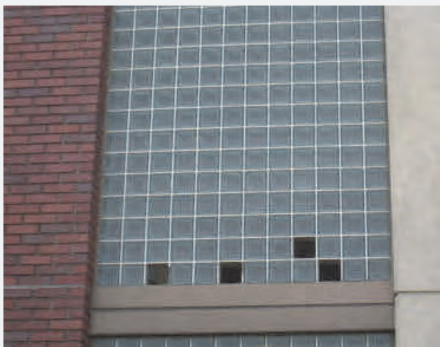
〈修理中〉 破損箇所のガラス撤去
