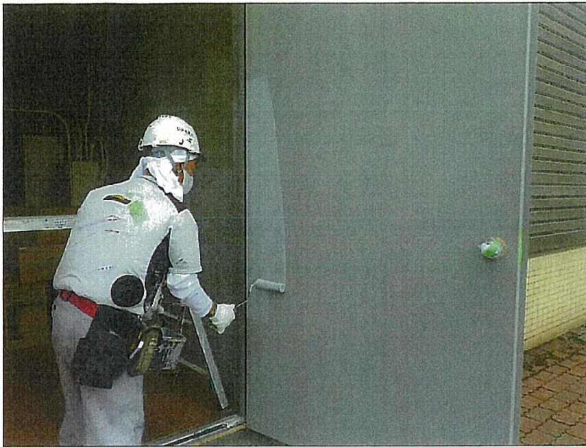
写真区分: 塗装工事 工種: 施工状況 写真タイトル: 下地処理 (ザビ止め塗布)
