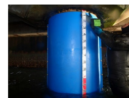
鋼管杭の被覆防食の更新
