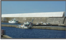
防波堤の嵩上げによる越波対策
