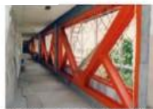
鉄骨ブレースによる壁の補強
