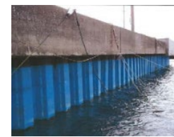
岸壁、鋼製矢板の腐食対策
