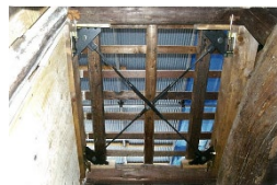
構造用合板補強（床・壁の内部）
