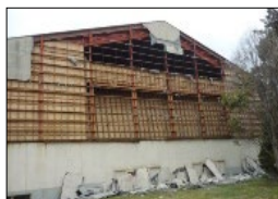
外壁の全面的な脱落事例
