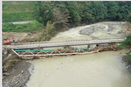
＜被災して崩落した水道管＞
