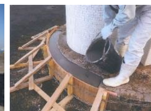
▲亀裂補修(環境遮断)
