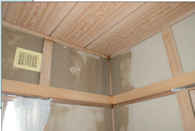
〈実際のすが漏れの様子〉
